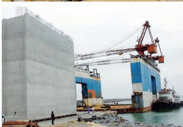
Complexe industriel portuaire de Kribi en chantier
