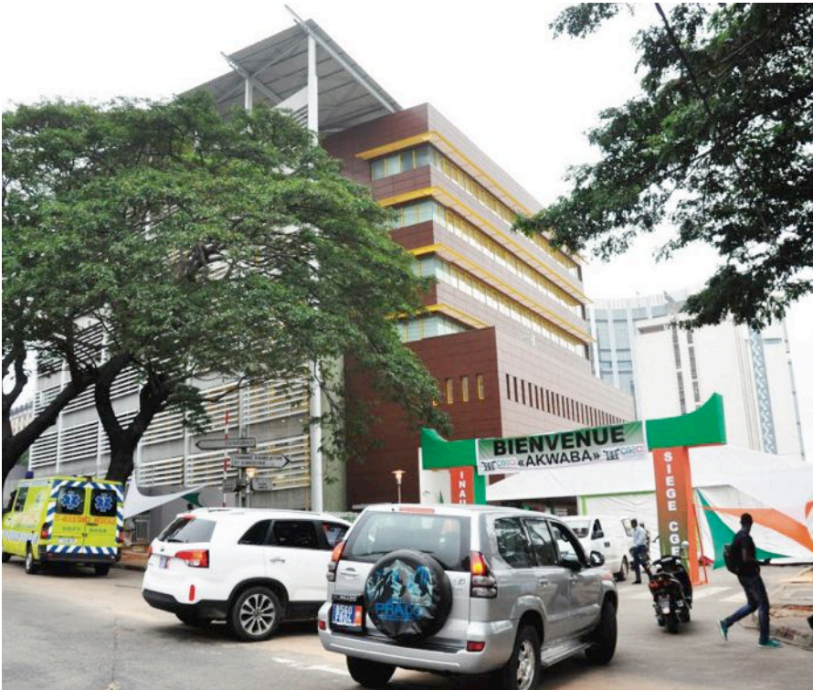
Immeuble siège CGECI
